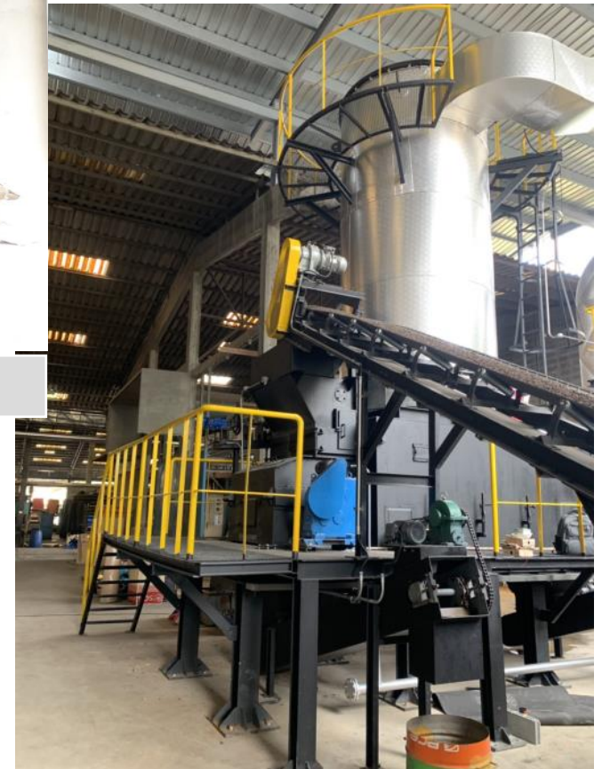
หม้อน้ำร้อนที่ใช้เชื้อเพลิงชีวมวล
