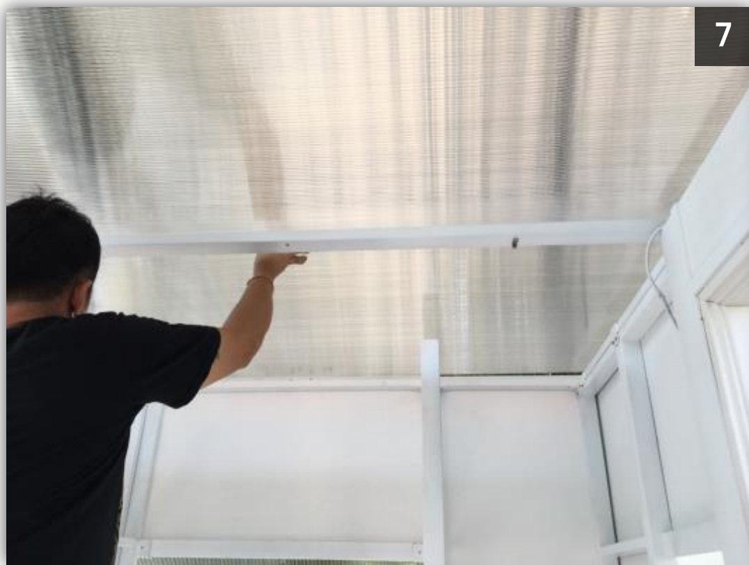
ติดตั้งพนักบน
