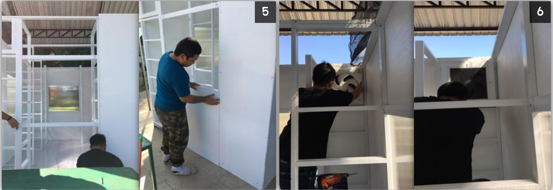
ติดตั้งผนัง
