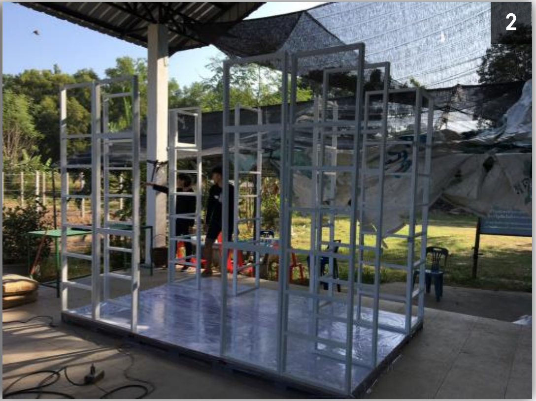
ตั้งโครงเสา 12 ชุด
