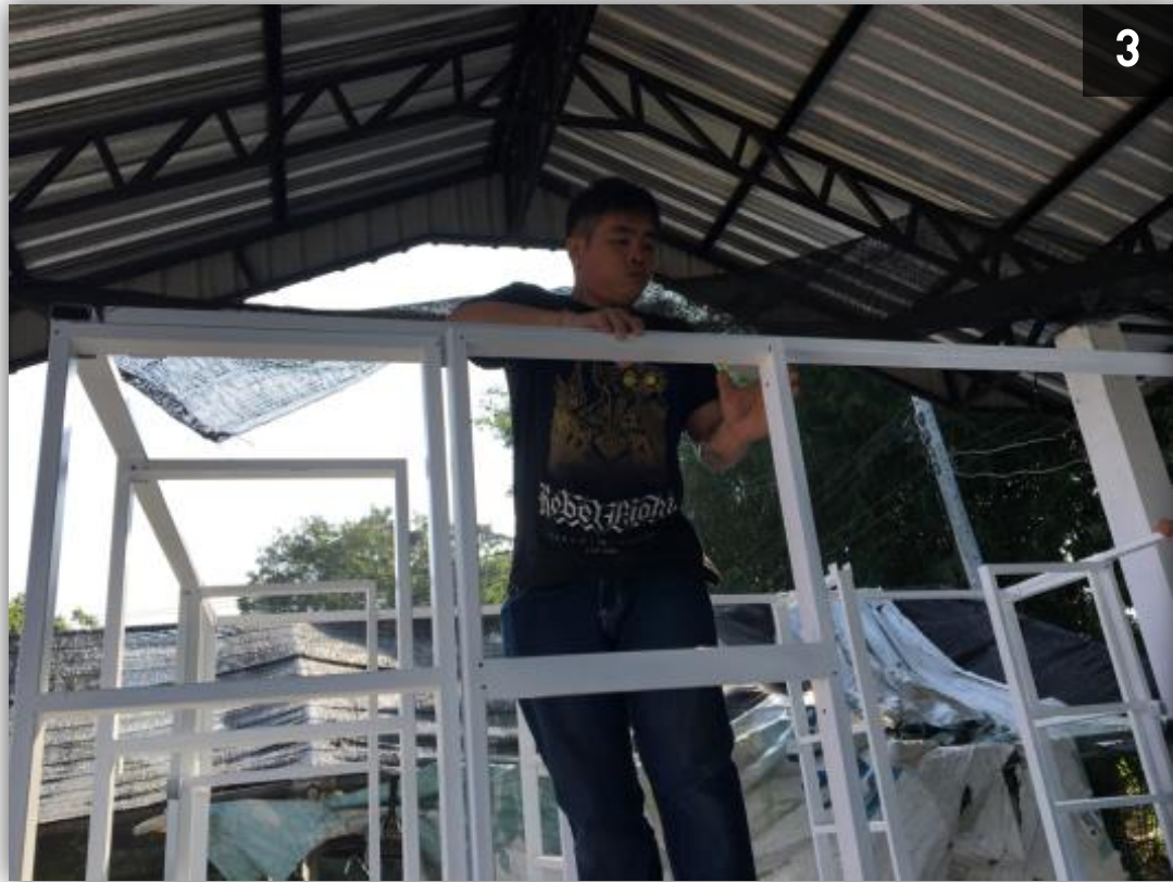
ติดตั้งคาน
