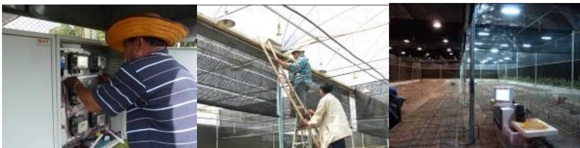
ภาพที่ ๒ การซ่อมแซมระบบไฟฟ้าแสงสว่างในโรงเรือนต้นแบบสำหรับทดสอบการผลิตปทุมมานอกฤดู
