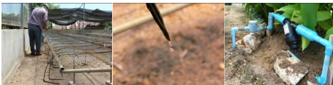
ภาพที่ ๓ การตรวจสอบระบบการให้น้ำแบบหยดพร้อมทั้งติดตั้งชุดกรองน้ำขนาด ๑๒๐ เมช เพิ่มเติม
