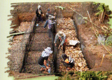
ฝาย ทำโดยขุดฐานลึกลงไปได้ดิน ปลูกหญ้าเป็นก่องเรียงกัน บดอัดกันให้แน่นหนา แล้วใส่หินลงก่องปิดฝาให้แน่น จากนั้นจึงเทหินส่วนที่เหลือกับชั้นบน
