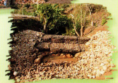
ฝาย ทำโดยขุดฐานลึกลงไปได้ดิน ปลูกหญ้าเป็นก่องเรียงกัน บดอัดกันให้แน่นหนา แล้วใส่หินลงก่องปิดฝาให้แน่น จากนั้นจึงเทหินส่วนที่เหลือกับชั้นบน
