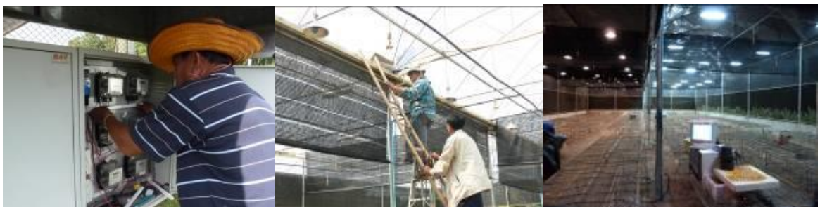
ภาพที่ 2 การซ่อมแซมระบบไฟฟ้าแสงสว่างในโรงเรือนต้นแบบสำหรับทดสอบการผลิตปทุมมานอกฤดู
