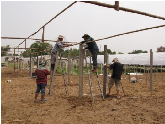
รูปที่ 23 ขึ้นโครงหลังคาโรงเรือน
