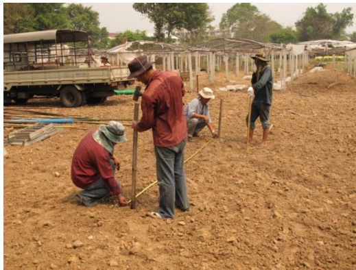
รูปที่ 19 วัดระยะและกำหนดตำแหน่งเสาโรงเรือน
