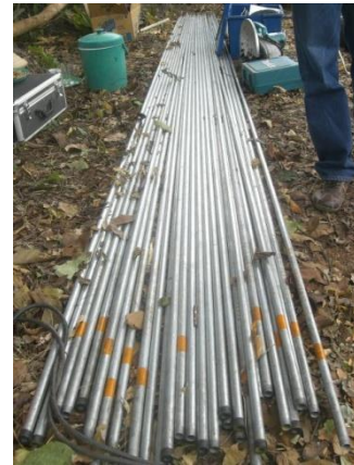
รูปที่ 2 เตรียมท่อขนาด ½ นิ้ว ที่จะตัดโค้ง
