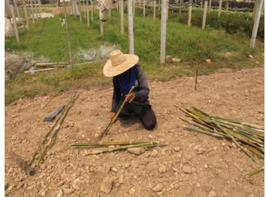
รูปที่ 12 ตัดไม้รวกยาว 1 ม. เสียบปลายแหลมเพื่อใช้ตอกเป็นหลักไว้ยึดโครงเหล็ก
