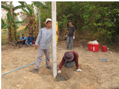
รูปที่ 21 เทคอนกรีตในหลุมเพื่อยึดเสาให้แข็งแรง
