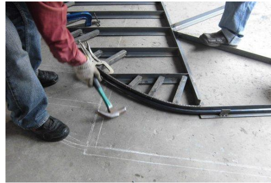
รูปที่ 8 ใช้ค้อนเคาะให้ท่อเหล็กแนบกับแบบมากขึ้น โดยเฉพาะบริเวณส่วนโค้ง
