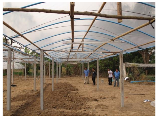
รูปที่ 28 ติดตั้งหลอดไฟฟ้าใต้สันหลังคา
