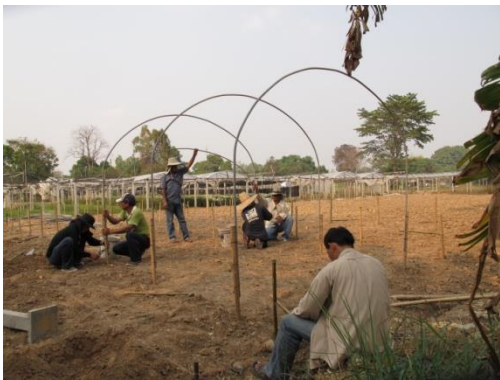
รูปที่ 13 ขึ้นโครงเหล็กที่ตัดโค้งทุกระยะ 1.5 ม.
