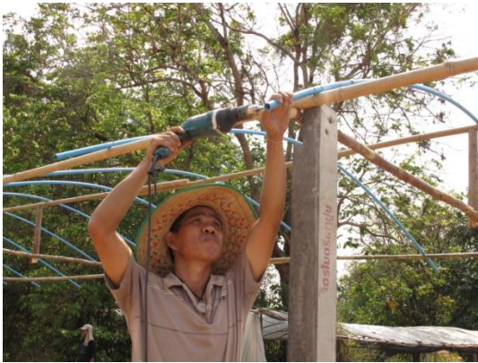
รูปที่ 25 ส่วนงานเจาะรูที่ปลายท่อพีวีซีเพื่อใช้เป็นรูร้อยลวดยึดท่อพีวีซีที่เป็นขอบชายคา
