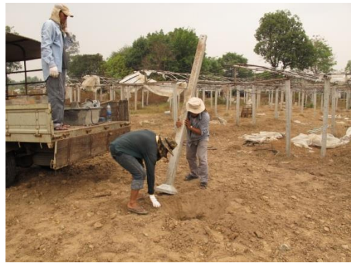
รูปที่ 20 ขุดหลุมลึกประมาณ 50 ซม.ลงเสาโรงเรือน
