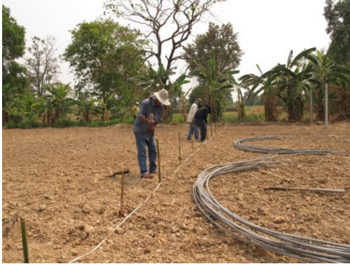
รูปที่ 11 วัดระยะและกำหนดตำแหน่งเสาโรงเรือน
