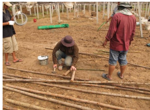
รูปที่ 22 ตัดไม้ยูคาลิปตัสเพื่อทำโครงหลังคา
