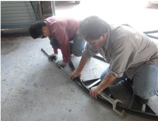
รูปที่ 7 ติดเหล็กและล๊อคให้แนบกับแม่แบบไปจนสุดปลายท่อ
