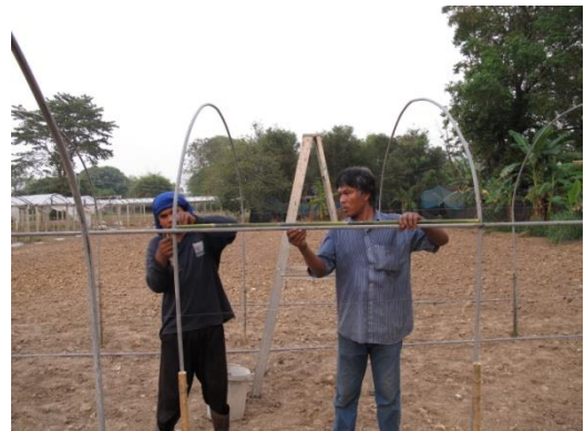
รูปที่ 14 ท่อนเหล็กตรงขนาดด้านข้าง 2 ด้าน และบนสันโรงเรือน
