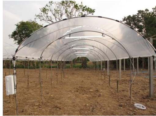
รูปที่ 18 ติดตั้งหลอดไฟฟ้าได้สันหลังคาโครงเว้นโครง
