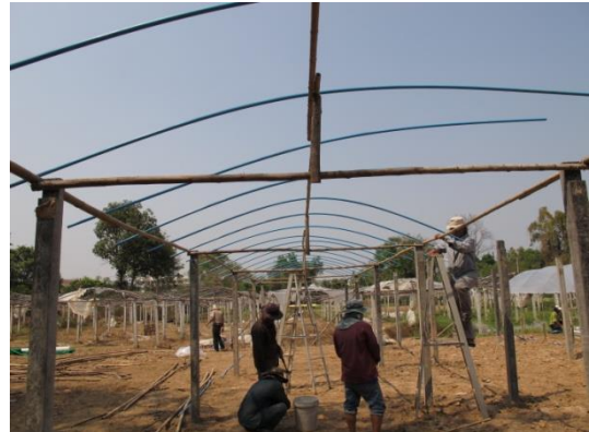
รูปที่ 24 ใช้ท่อพีวีซีดัดโค้งเป็นโครงหลังคา
