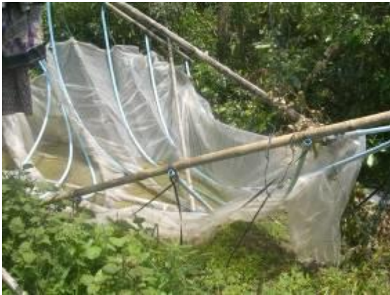
รูปที่ 5 ปัญหาความเสียหายจากลมเนื่องจากโรงเรือนไม่แข็งแรง
