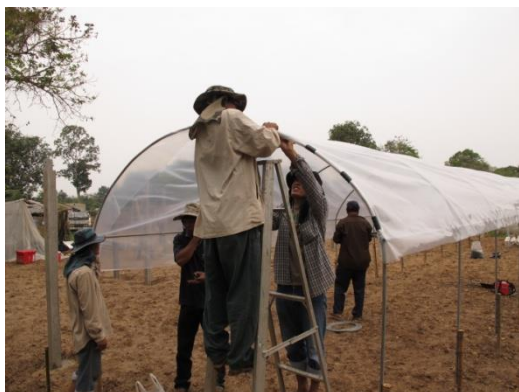
รูปที่ 15 มุงหลังคาด้วยพลาสติกใสโดยยึดชายด้วยคลิป ยึดแผ่นพลาสติกโรงเรือน
