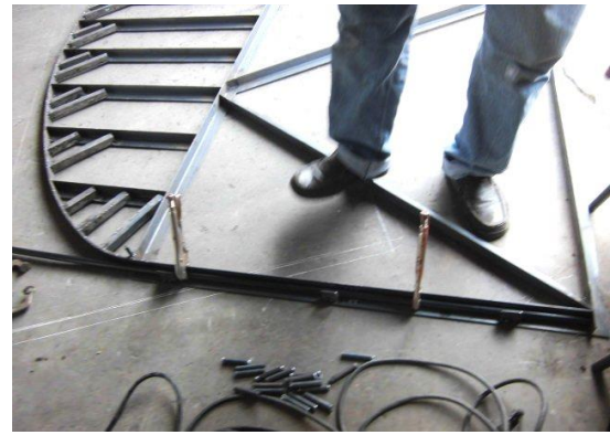
รูปที่ 4 นำท่อเหล็ก ½ นิ้ว ใส่ช่องด้านข้าง (ซ้าย) ของแม่แบบ
