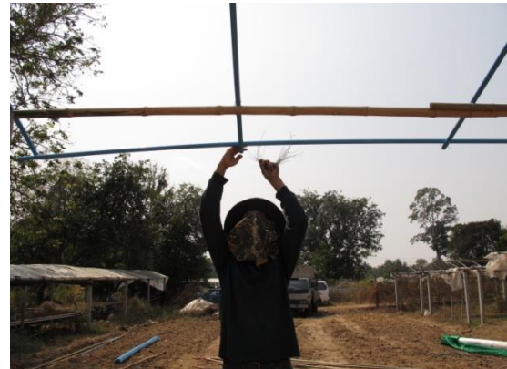
รูปที่ 26 ใช้ท่อพีวีซี 1/2 นิ้ว เป็นขอบชายคาเพื่อใช้ล็อกพลาสติกมุงหลังคา
