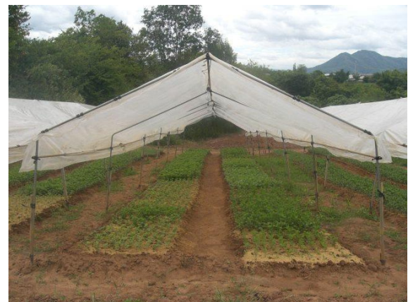
รูปที่ 4 โรงเรือนต่ำโครงหลังคาเหล็กรูปจั่ว
