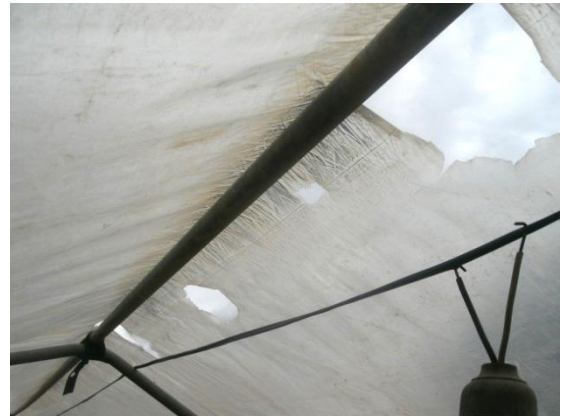
รูปที่ 6 ปัญหาหลังคาพลาสติกขาดง่ายจากลมพัดเนื่องจากสันจั่วเป็นมุมแหลม
