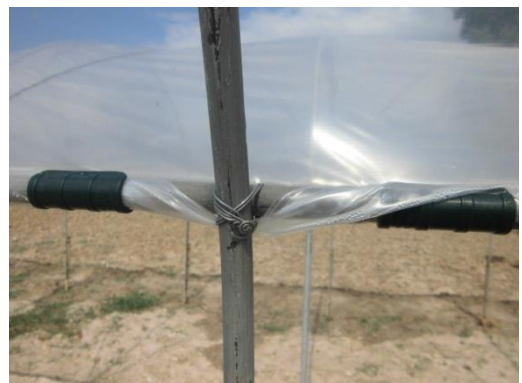
รูปที่ 16 การยึดท่อเหล็กที่ขนาดตามยาวโรงเรือนกับโครงเหล็กและการยึดชายพลาสติกด้วยคลิป
