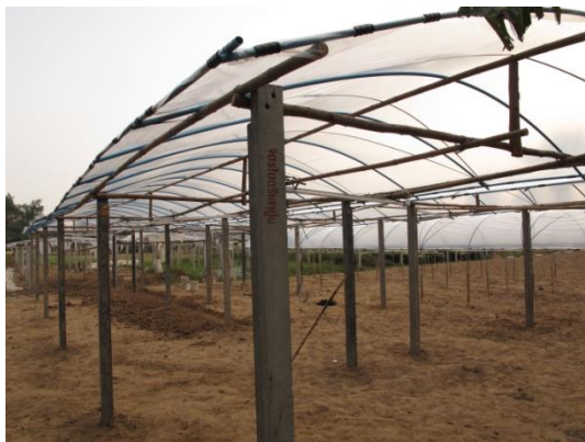
รูปที่ 27 มุงพลาสติกหลังคาแล้วใช้สายรัดโรงเรือนรัดกับท่อโค้งพีวีซีโครงหลังคาโดยรัดไขว้ปลายท่อโค้งสลับกัน
