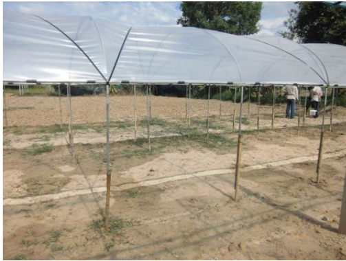
รูปที่ 17 ใช้สายรัดพลาสติกโรงเรือนรัดหลังคาโดยรัดไขว้เสาเว้นเสา
