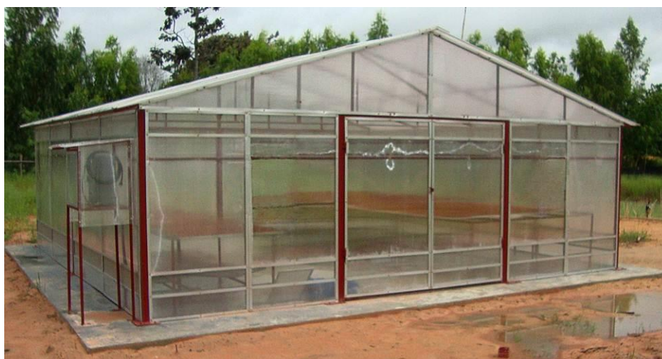
ภาพที่ 4 โรงตากแห้งพลังงานแสงอาทิตย์สะสมความร้อนแบบภาวะเรือนกระจก
