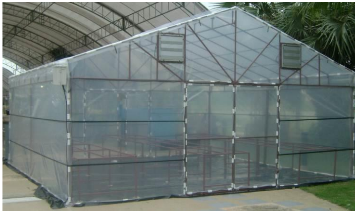
ภาพที่ 2 โรงอบแห้งพลังงานแสงอาทิตย์สะสมความร้อนแบบภาวะเรือนกระจก
