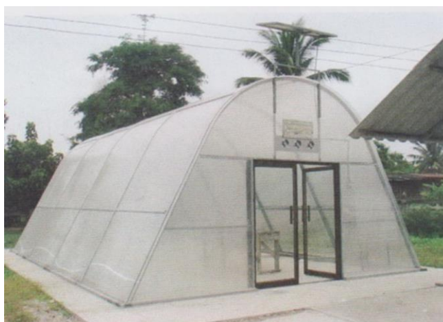
ภาพที่ 1 โรงอบแห้งพลังงานแสงอาทิตย์รูปทรงพาราโบลา กรมพัฒนาพลังงานทดแทนและอนุรักษ์พลังงาน กระทรวงพลังงาน ร่วมกับ ภาควิชาฟิสิกส์ คณะวิทยาศาสตร์ มหาวิทยาลัยศิลปากร
