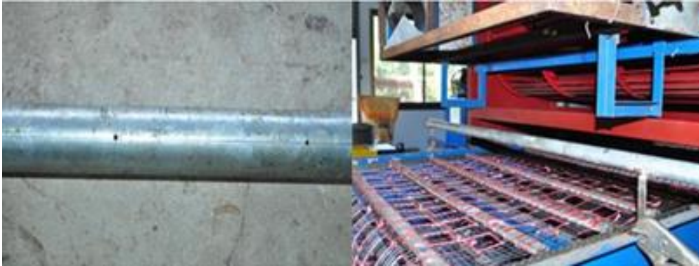
รูปที่ 17 ชุดท่อลมเป่าน้ำใต้ก๊อบลี้อย่างและติดตั้งชุดเป่าน้ำด้านบนชุดลำเลียง
