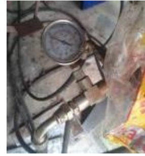
รูปที่ 10 อัดที่แรงดัน 100 บาร์
