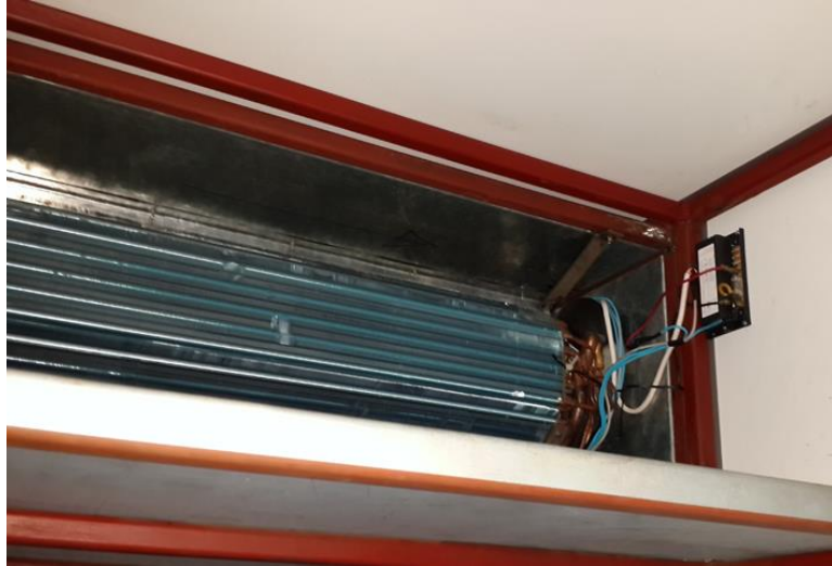
รูปที่ 12 ติดตั้งอุปกรณ์วัดอุณหภูมิ หลังคอร์ยเย็น
