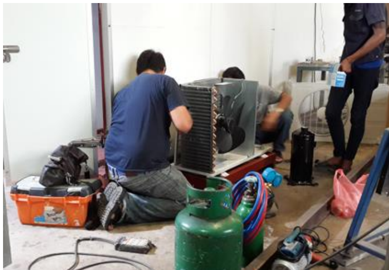
รูปที่ 13 ติดตั้งระบบทำความเย็น
