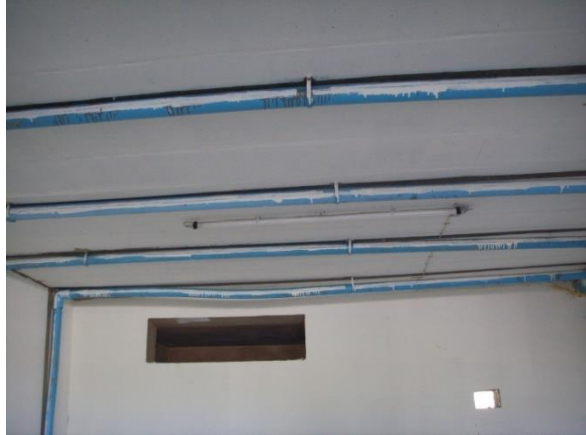
ภาพที่ 1 โรงรมแบบที่ 2 ใช้ท่อและปั๊ม ช่วยในการกระจายตัวของแก๊สซิลเฟอร์ไดออกไซด์ 2 โรง
