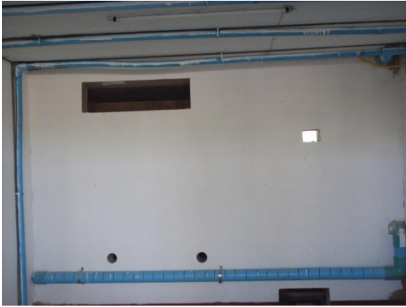
ภาพที่ 1 โรงรมแบบที่ 2 ใช้ท่อและปั๊ม ช่วยในการกระจายตัวของแก๊สซิลเฟอร์ไดออกไซด์ 2 โรง
