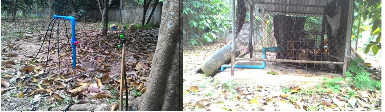
ภาพที่ 20 การติดตั้งระบบน้ำในรูปแบบสปริงเคลอร์
