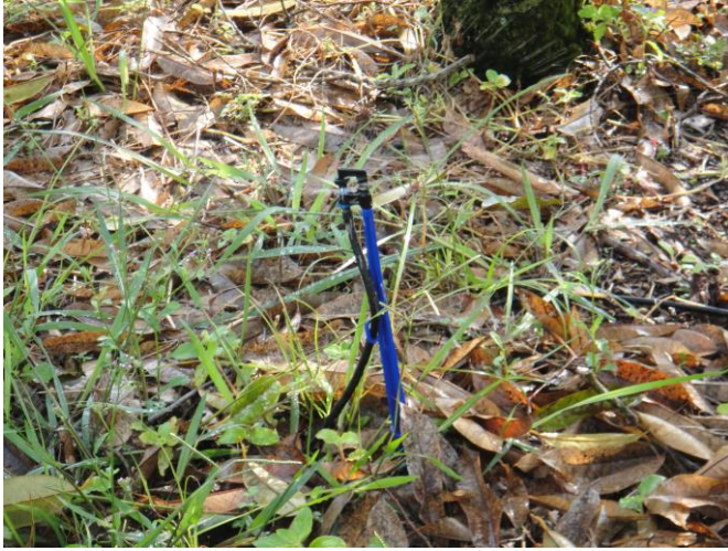
ภาพที่ 3 ระบบน้ำแบบ mini sprinkler ติดตั้งใต้โคนต้นทุเรียน
