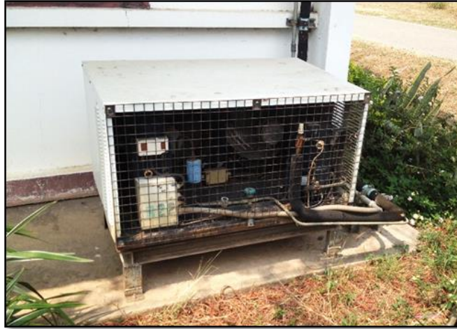
ภาพที่ 7 เครื่องทำความเย็นที่ใช้ร่วมกับฮีทเตอร์ไฟฟ้า
