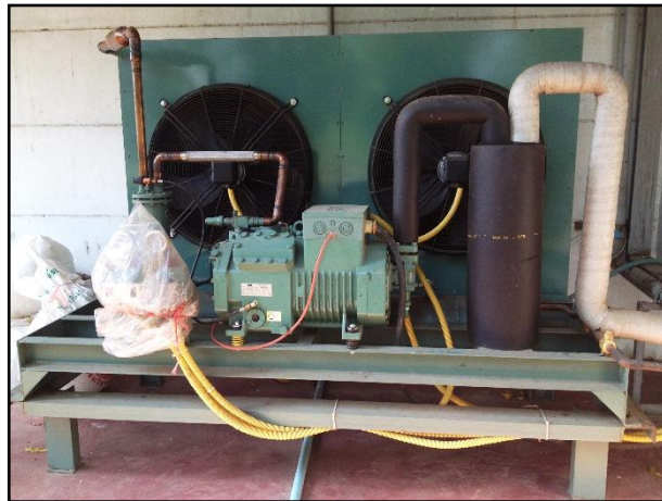
ภาพที่ 4 เครื่องทำความเย็นแบบ Air Cooled Condensing Unit
