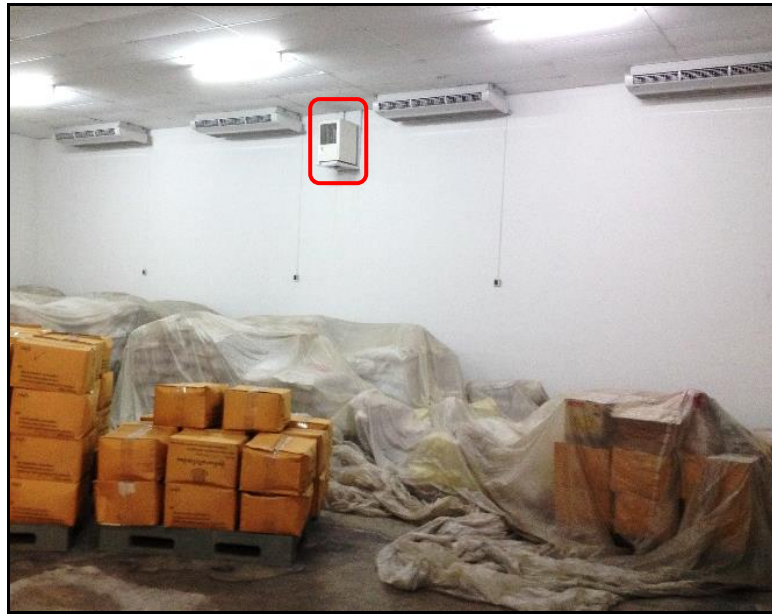
ภาพที่ 3 ห้องเย็นที่ใช้เครื่องลดความชื้นร่วมกับเครื่องปรับอากาศแบบทั่วไป
