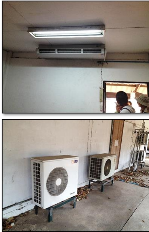
ภาพที่ 1 ห้องเย็นที่ใช้เครื่องปรับอากาศแบบตู้ทั่วไป (Split type)
