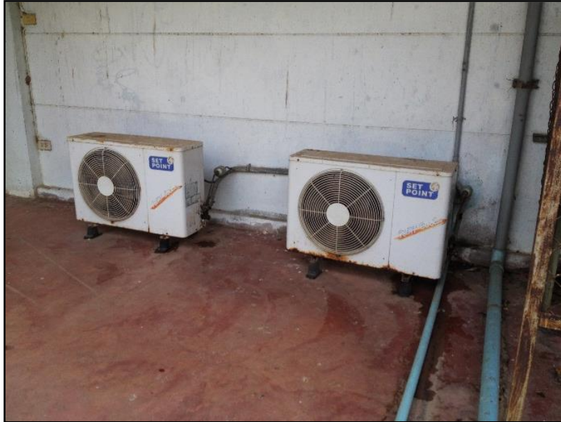
ภาพที่ 6 ระบบทำความเย็นที่ใช้สำหรับเครื่องลดความชื้น
