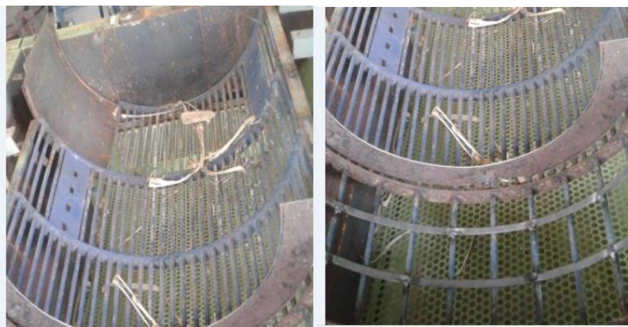
ลักษณะตะแกรงล่างก่อนการปรับปรุง ลักษณะตะแกรงล่างหลังการปรับปรุง
