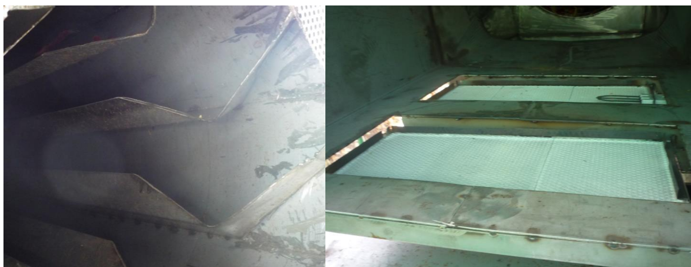
รูปที่ 6 รูปครีบท่ออุโมงค์ยกขึ้นตรงทางเข้า และเต้าแก๊ส 2 เต้า
