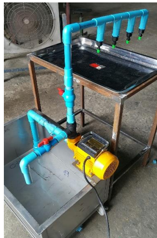
ภาพที่ 2 ระบบควบคุมการพ่นฝอยน้ำเย็น
