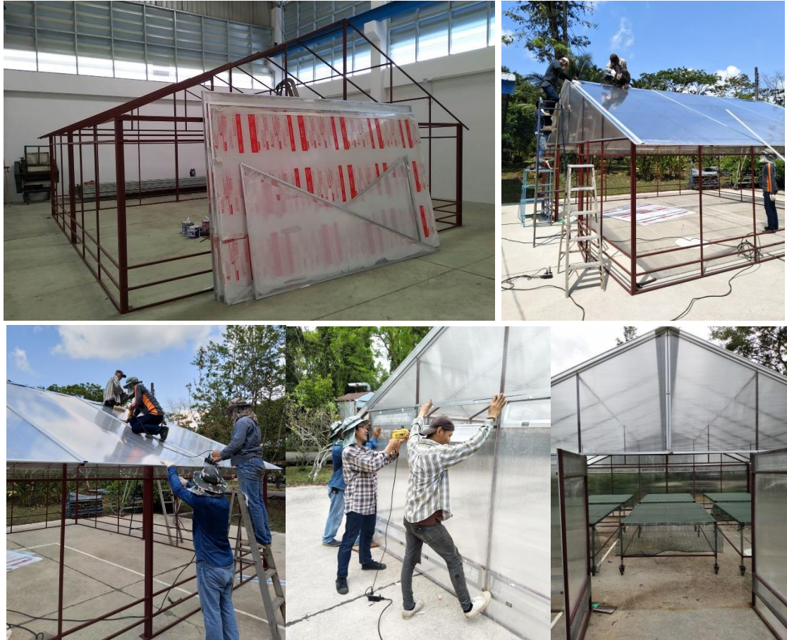
รูปที่ 10 การสร้างโรงตากพลังงานแสงอาทิตย์
