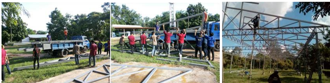
ภาพที่ 6 การขนย้ายและประกอบติดตั้งชิ้นส่วนโครงสร้างโรงเรือนตามแบบ ณ สวพ.4
