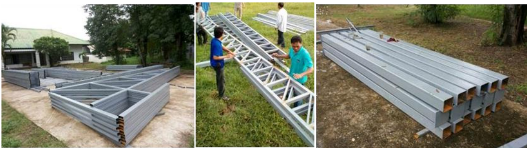
ภาพที่ 5 การเชื่อมประกอบโครงสร้างโรงเรือนเป็นชิ้นๆ ณ ศวศ.ขอนแก่น เพื่อเตรียมไปประกอบหน้างาน
