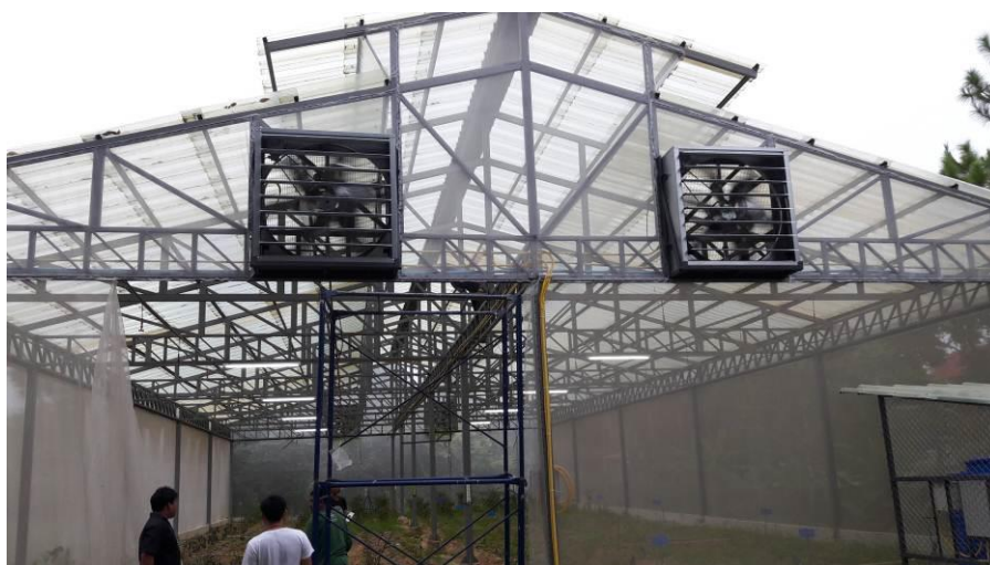
ภาพที่ 16 การติดตั้งพัดลมระบายอากาศในโรงเรือนปลูกพริก
