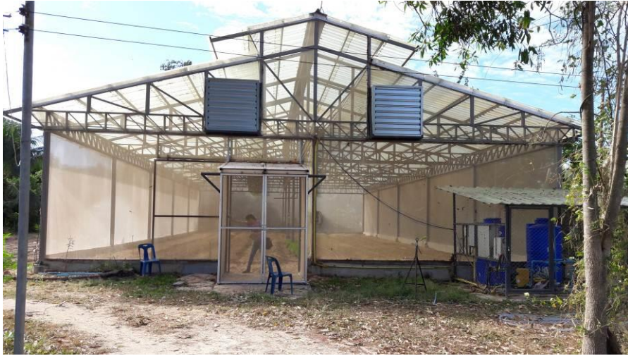
ภาพที่ 21 โรงเรือนปลูกพริก ขนาด 14.0 x 30.0 x 3.5 เมตร (420 ตรม.)
