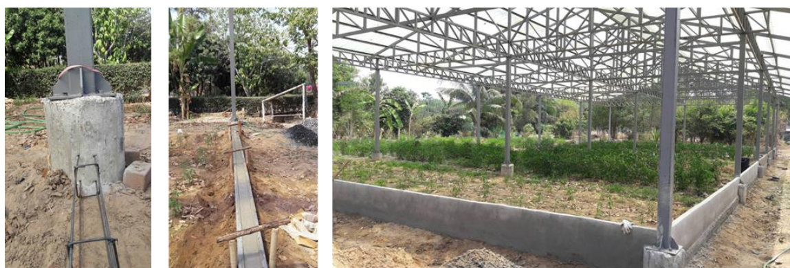
ภาพที่ 12 เทคนิครับ และการก่อแนวอิฐบล็อกสูง 2 ก้อนอิฐบล็อก รอบโรงเรือน
