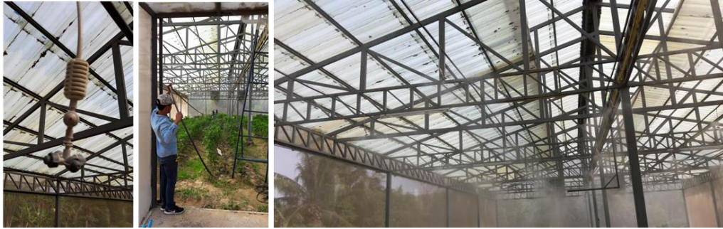
ภาพที่ 14 การติดตั้งหัวพ่นหมอกพร้อมทดสอบความละเอียดของละออง
