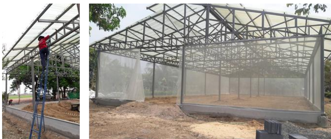
ภาพที่ 13 ทำการติดมุ้งตาข่ายกันแมลงความถี่ 32 mesh โดยรอบโรงเรือนและส่วนที่เป็นช่องเปิด
