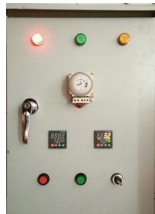
ภาพที่ 31 ตู้คอนโทรลแบบใช้หัวสปาร์คด้วยไฟฟ้าจุดหัวเผา และตั้งเวลาตัดต่ออุณหภูมิเป็น 2 ช่วงเวลา
