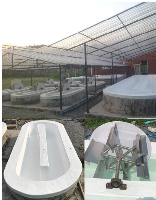
ภาพที่ 2 เคลือบบ่อเพาะเลี้ยงสาหร่ายด้วยไฟเบอร์กลาสและติดตั้งวัสดุโปร่งแสงคลุมบ่อ
