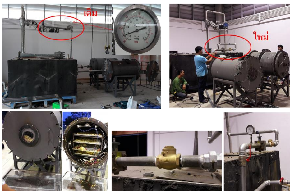
ภาพที่ 19 การติดตั้งวาล์วกันน้ำไหลย้อนกลับเข้าเครื่องอบแห้ง
