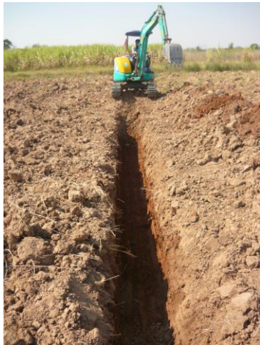
(ก) แนวร่องเพื่อติดตั้งท่อระบายน้ำใต้ดิน
