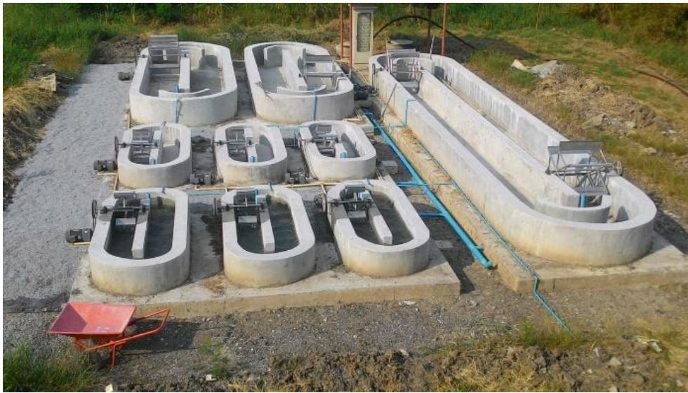
ภาพที่ 7 แสดงการติดตั้งระบบท่อระบายน้ำทั้ง ระบบเติมน้ำและอาหารเหลว
