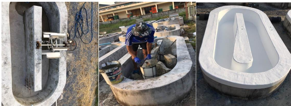
ภาพที่ 9 แสดงการบังคับทิศทางการไหลของน้ำเพื่อแก้ปัญหา Dead Zone ภายในบ่อเพาะเลี้ยงสาหร่าย
