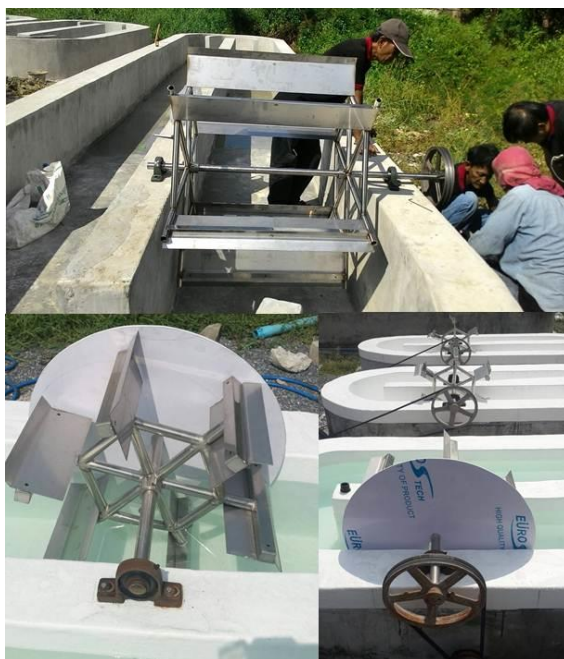
ภาพที่ 10 แสดงการติดตั้งระบบบำบัดของบ่อเพาะเลี้ยงสาหร่ายขนาดเล็ก
