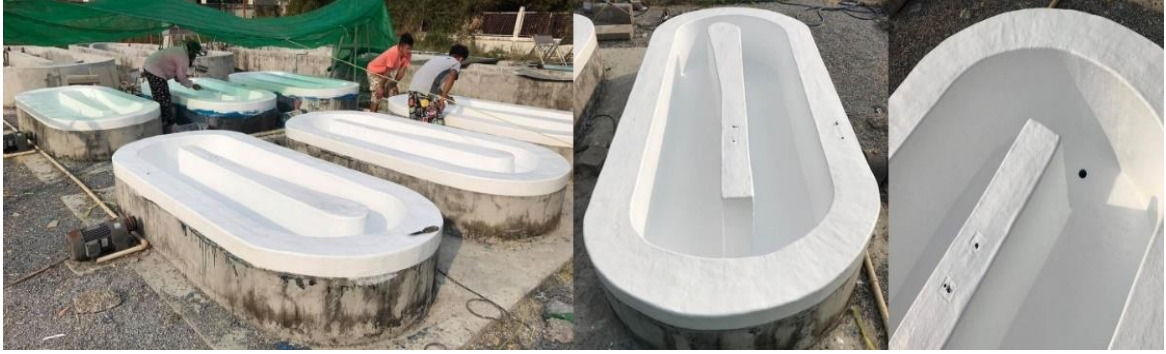
ภาพที่ 8 แสดงการเคลือบบ่อเพาะเลี้ยงสาหร่ายด้วยไฟเบอร์กลาส
