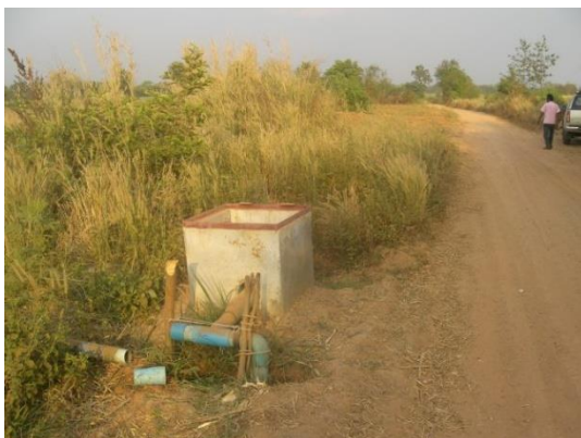
ภาพที่ 1 ระบบท่อส่งน้ำสำหรับไร่อ้อยของโครงการสูบน้ำด้วยไฟฟ้า
