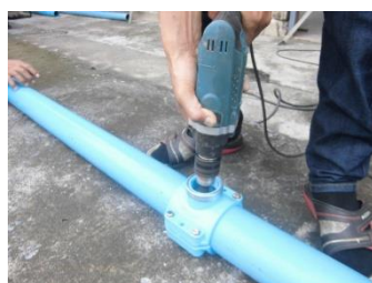
(ง) เจาะท่อด้วยสว่าน 38 มม.
