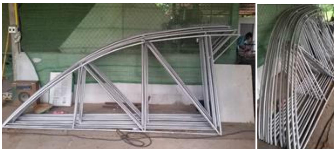
รูปที่ 3 การสร้างโครงสร้างหลังคาเหล็กสำหรับมุงพลาสติกใส
