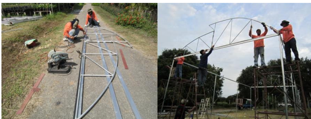
รูปที่ 5 การประกอบโครงสร้างและติดตั้งหลังคาโรงเรือน
