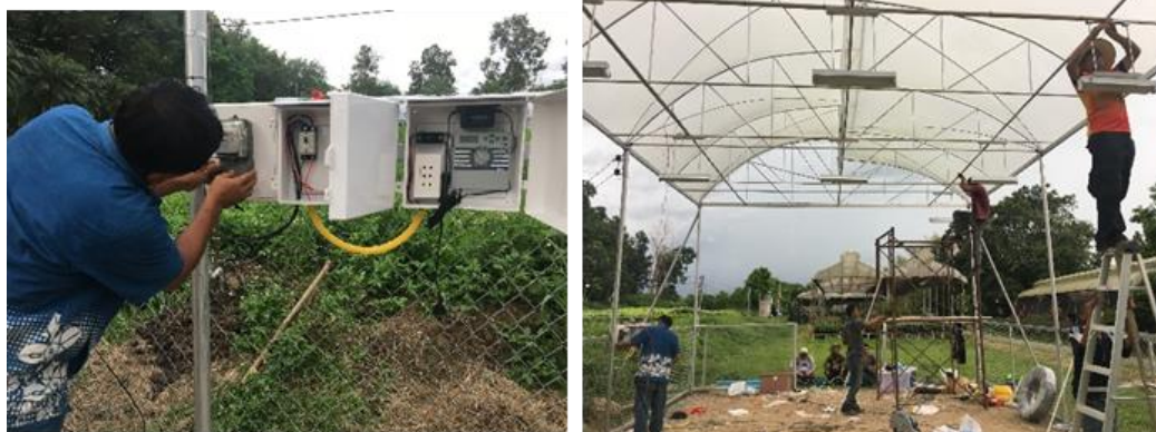
รูปที่ 11 ติดตั้งระบบควบคุมไฟฟ้าแสงสว่างในโรงเรือน
