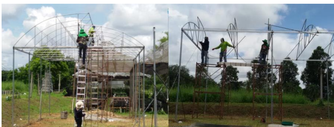
รูปที่ 6 การติดตั้งส่วนของหลังคาโค้งแบบเหลี่ยมสำหรับมุงพลาสติกใส
