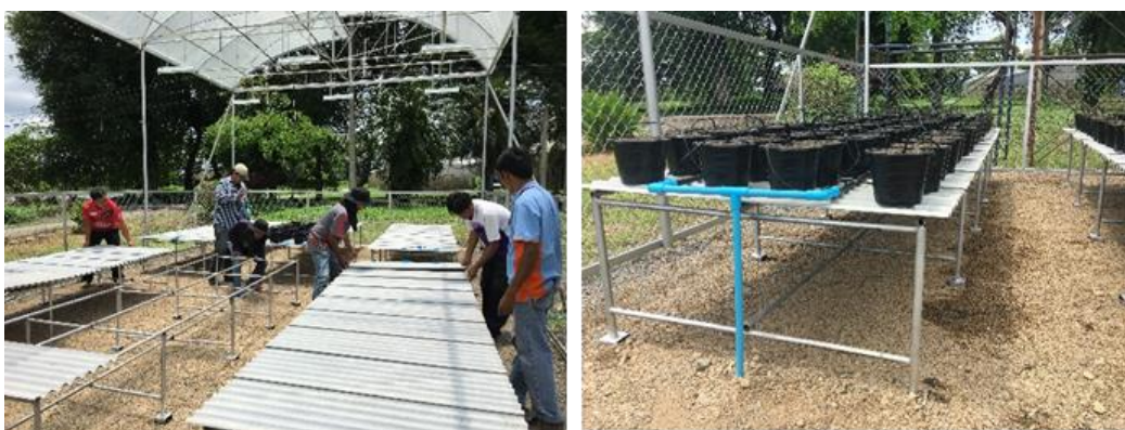
รูปที่ 12 ประกอบและติดตั้งโต๊ะสำหรับวางถาดปลูกปทุมมาจำนวน 6 ชุด
