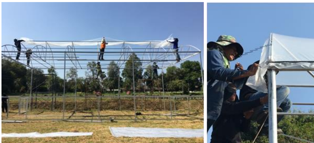
รูปที่ 7 การติดตั้งพลาสติกมุงหลังคาโรงเรือน
