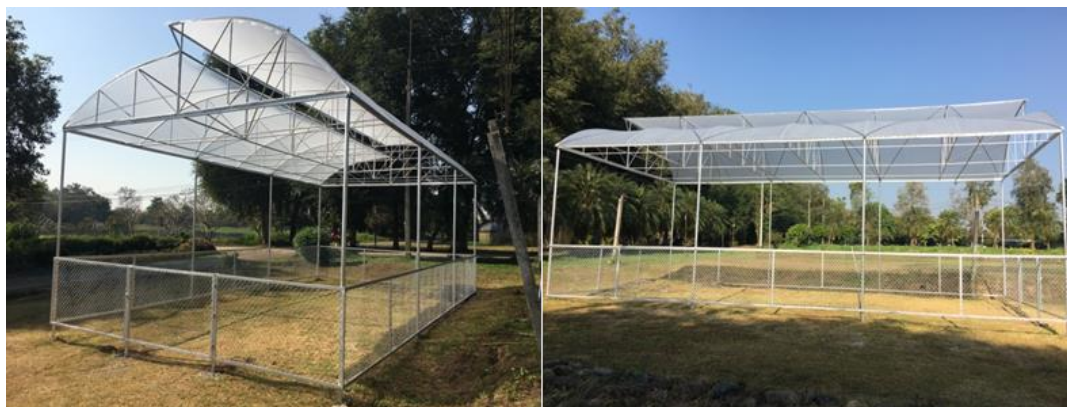
รูปที่ 8 โรงเรือนหลังคาโค้งเหลี่ยมมุงพลาสติกขนาด 150 ไมครอน
