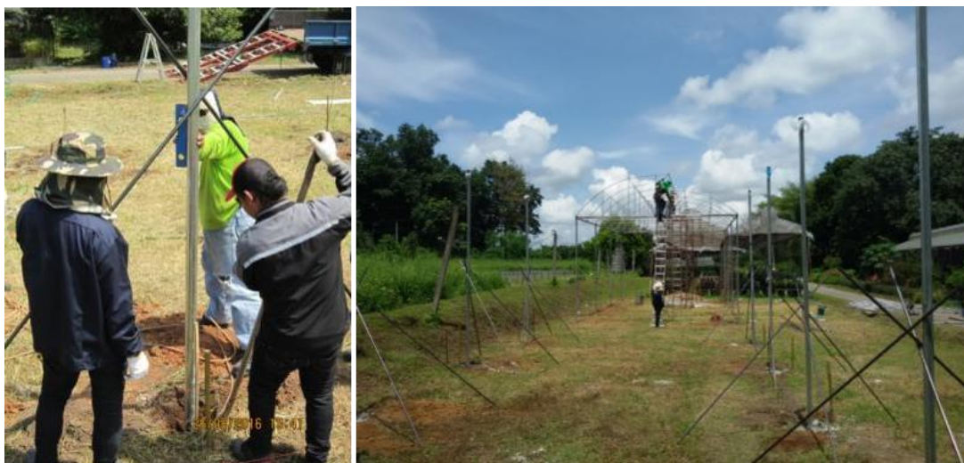
รูปที่ 4 การตั้งเสา เเทคอนกรีตทับ และโครงสร้างหลักของโรงเรือน
