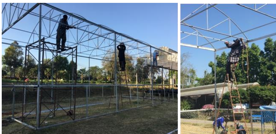
รูปที่ 10 การติดตั้งโครงเหล็กสำหรับการติดตั้งระบบไฟฟ้าแสงสว่าง
