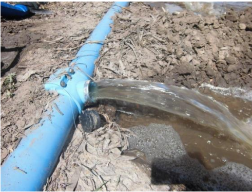
ภาพที่ 4 ท่อเปิดแบบท่อแข็ง (พีวีซี)
