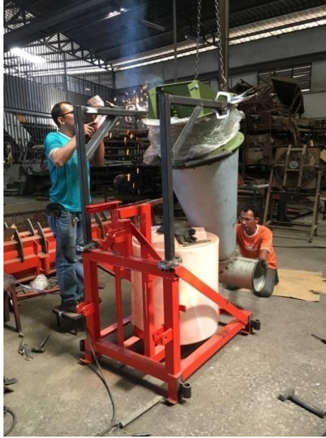
รูปที่ 6 ติดตั้งพัดลมต้นแบบกับอุโมงค์ลม
