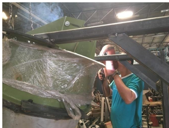
รูปที่ 5 ติดตั้งพัดลมต้นแบบ
