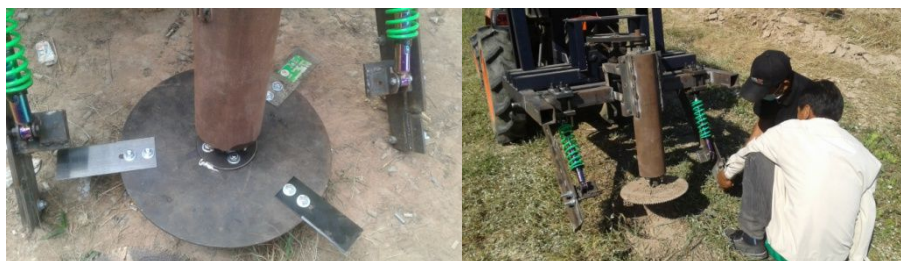
รูปที่ 5 ตำแหน่งการติดตั้งใบมีด
