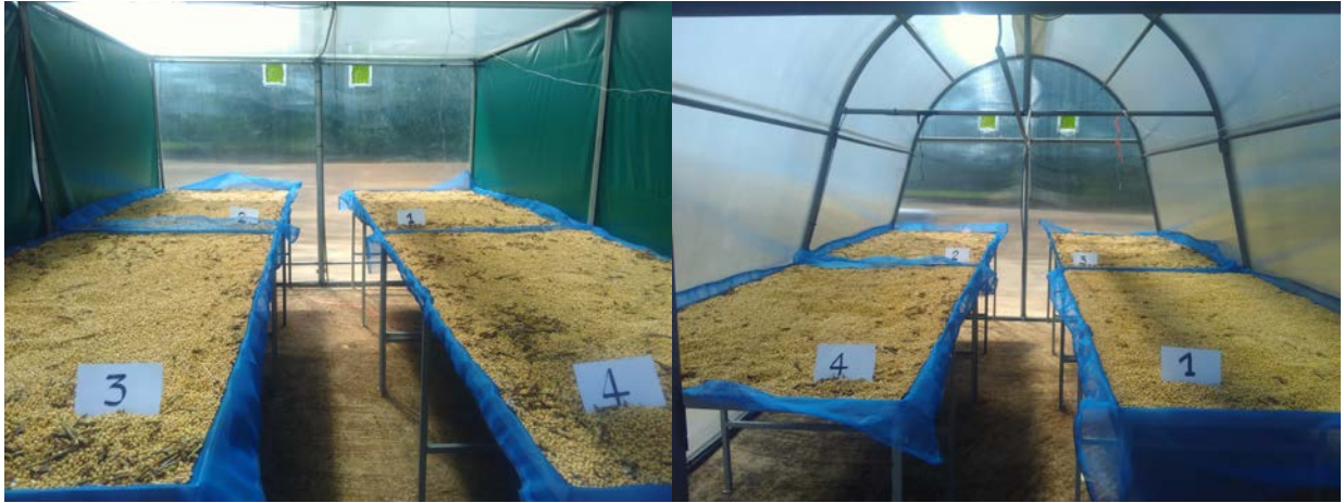
ภาพที่ 16 แสดงโครงสร้างภายในโรงตากทั้งทรงหลังคาหน้าจั่ว และทรงหลังคาโค้ง ที่ดำเนินการประกอบเรียบร้อยแล้ว พร้อมทั้งจัดตั้งชั้นตากถั่วเหลืองภายในโรงตาก สำหรับใช้เปรียบเทียบกับกรรมวิธีของเกษตรกร ซึ่งทำการติดตั้งเรียบร้อยแล้วที่สถานีแปลงทดลองของศูนย์วิจัยพืชไร่เชียงใหม่ (พรวัว) อ.พรวัว จ.เชียงใหม่ เพื่อเตรียมทดลองในช่วงเก็บเกี่ยวผลผลิตปลายฤดูฝน ปี 2560
