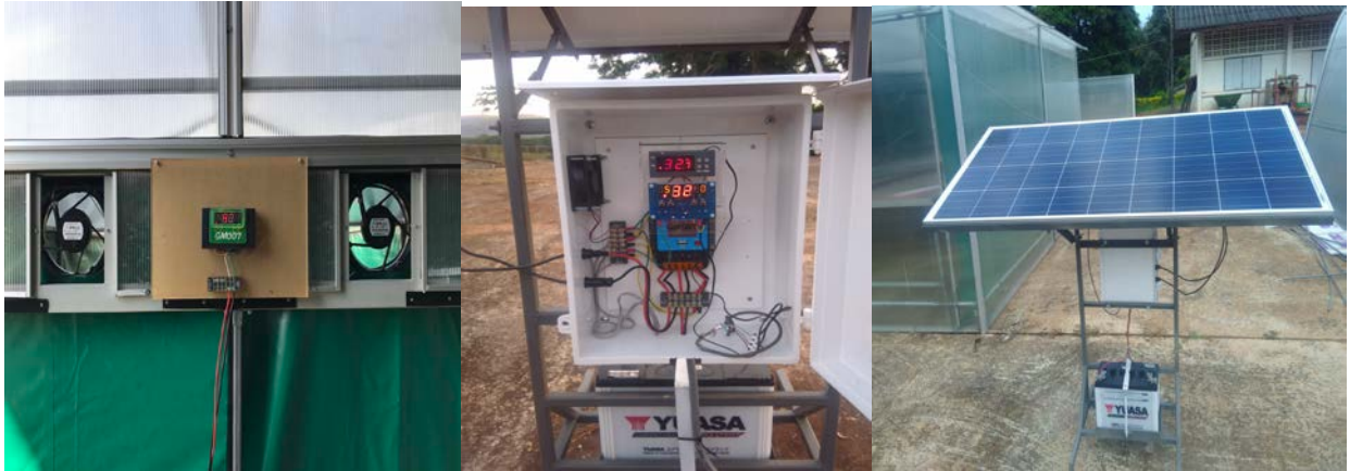
ภาพที่ 13 แสดงอุปกรณ์วัดอุณหภูมิภายในโรงตาก ที่เชื่อมต่อกับพัดลมดูดอากาศ และแผงโซล่าเซลล์ที่ใช้เป็นแหล่งพลังงานให้กับระบบอิเล็กทรอนิกส์ต่างๆที่ใช้กับโรงตาก เพื่อควบคุมอุณหภูมิภายในโรงตาก ไม่เกิน 42-45 องศาเซลเซียส
