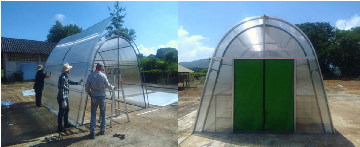
ภาพที่ 14 แสดงโรงตากทรงหลังคาโค้ง ที่ทำการประกอบพร้อมติดตั้งกับอุปกรณ์แผงโซล่าเซลล์ อุปกรณ์เก็บพลังงานแสงอาทิตย์ที่จัดเตรียมไว้ใช้รวมทั้งเชื่อมต่อกับพัดลมดูดอากาศ และอุปกรณ์วัดอุณหภูมิภายในโรงตาก เพื่อใช้ทดสอบประสิทธิภาพการลดความชื้นเมล็ดพันธุ์ถั่วเหลืองในฤดูฝนต่อไป
