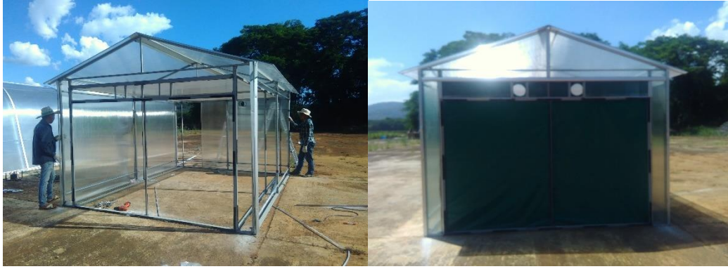
ภาพที่ 12 แสดงโรงตากทรงหลังคาน้ำจั่วที่ทำการปรับปรุงระบบ และประกอบโรงตากใหม่ เพื่อแก้ไขปัญหาดูแลอุณหภูมิภายในโรงตากที่สูง ด้วยการเพิ่มฝาผนังภายในโรงตาก ชั้นที่ 2 เพื่อเกิดช่องว่างระหว่างผนังสำหรับใช้ในการระบาย อากาศและการไหลเวียนอากาศร้อนภายในโรงตาก พร้อมกับติดตั้งพัดลมดูดอากาศเพิ่มเติม
