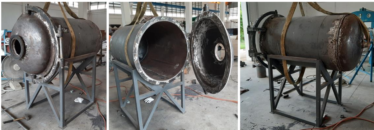
ภาพผนวก ข ที่ 4 การติดตั้งถังอบสุญญากาศบนฐานตั้งรับถัง
