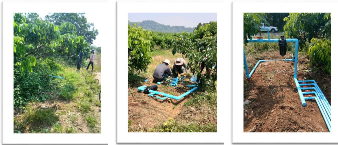
ภาพที่ 1 การติดตั้งระบบน้ำในแปลงลำไย
