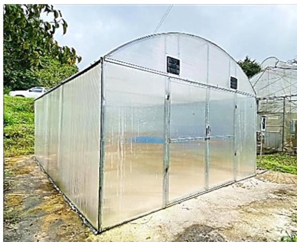
โรงอบแห้งกาแฟกะลาอะราบิก้าด้วยพลังงานแสงอาทิตย์
