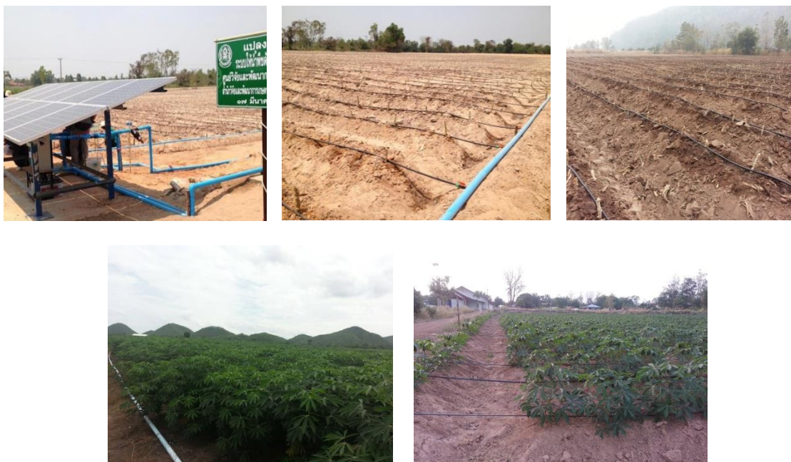
ภาพที่ 1 การให้น้ำด้วยระบบน้ำหยดโดยใช้พลังงานแสงอาทิตย์
