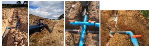
ประตุน้ำ แบบผีเสื้อ และ แบบบอลวาล์ว
