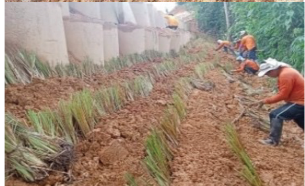
▲ แขวงทางหลวงน่านที่ 2 ทางหลวงหมายเลข 1081 - 0102 ตอน หลักลาย - บ่อเกลือ กม.70+200 - กม.70+400 และทางหลวงหมายเลข 1148 - 0101 ตอน ท่าวังผา - ผาหลัก กม.25+100 - กม.25+150
