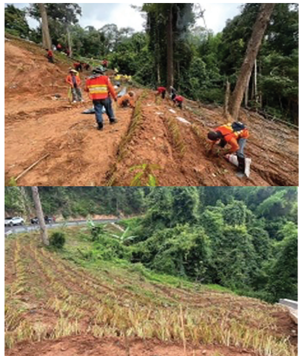
แขวงทางหลวงเชียงใหม่ที่ 2 ทางหลวงหมายเลข 1252 ตอน ปางแฟน - แม่ต๋อนหลวง กม.2+145
