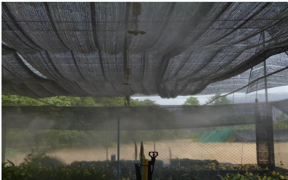
ภาพที่ 1 การใช้ตาข่ายพรางแสงร่วมกับการพ่นหมอกเพื่อควบคุมอุณหภูมิในโรงเรือน
