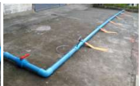
(ค) ท่อจ่ายน้ำตามร่องที่สวมท่ออ่อนป้องกันการกัดเซาะดิน
