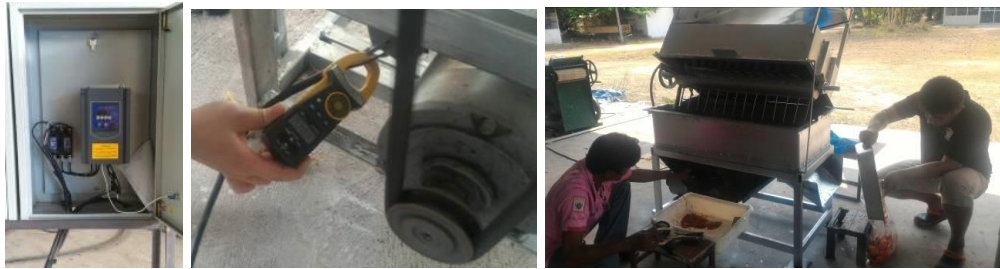
ภาพที่ 2.69 เครื่องปรับความเร็วรอบมอเตอร์ต้นกำลัง การวัดกระแสไฟฟ้า และการทดสอบการทำงานของเครื่องต้นแบบ
