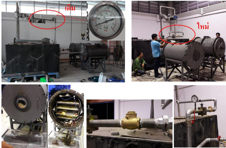
ภาพที่ 4.19 การติดตั้งวาล์วกันน้ำไหลย้อนกลับเข้าเครื่องอบแห้ง
