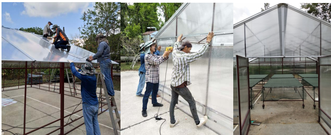
รูปที่ 10 การสร้างโรงตากพลังงานแสงอาทิตย์
